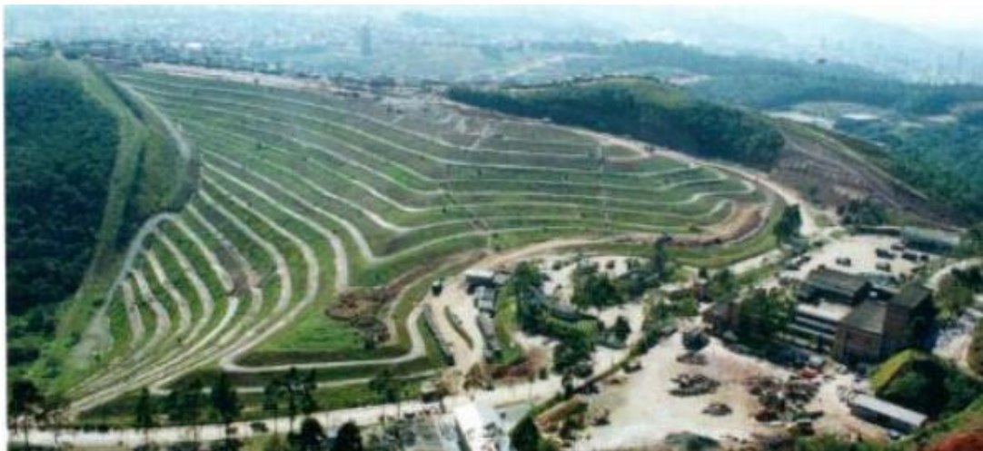
Figura 2. Aterro Sanitário Municipal de Santo André em 2001
