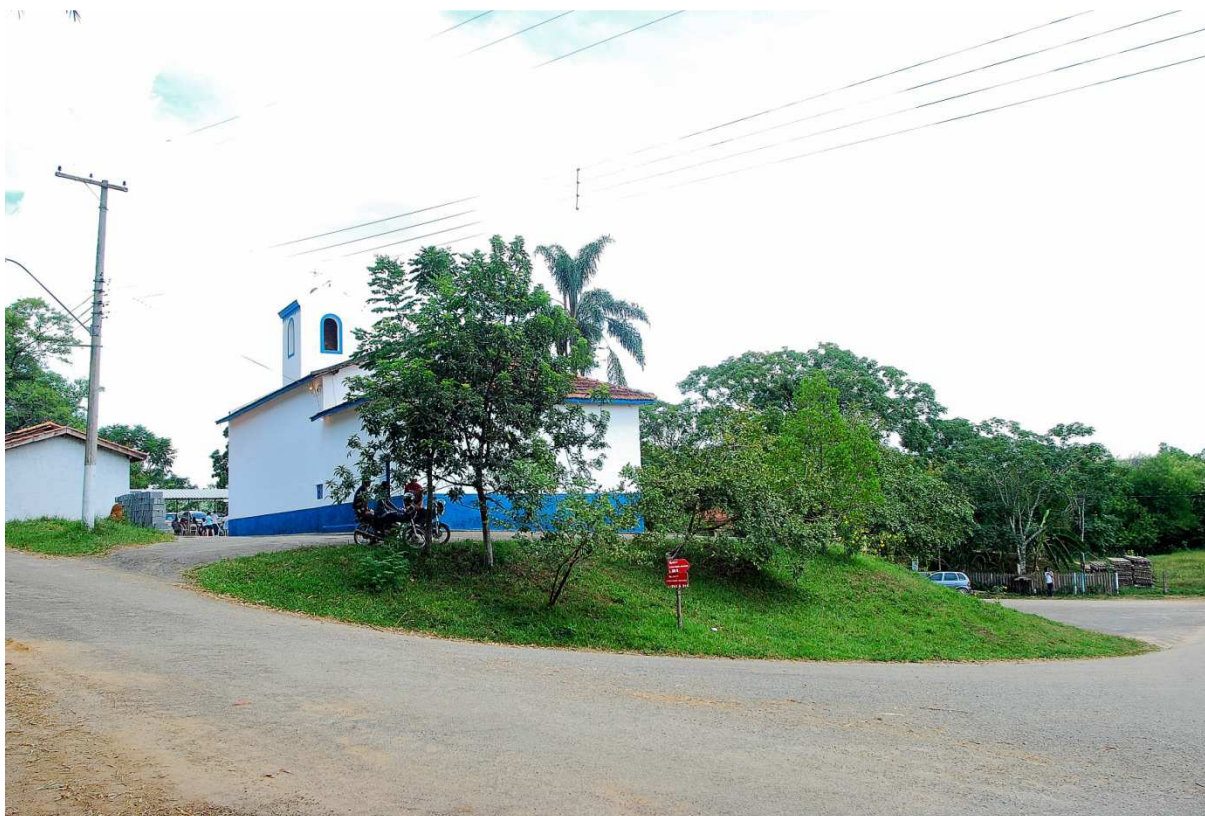
Foto 4 – Fundos da igreja Nossa Senhora dos Remédios (23/02/2014).
